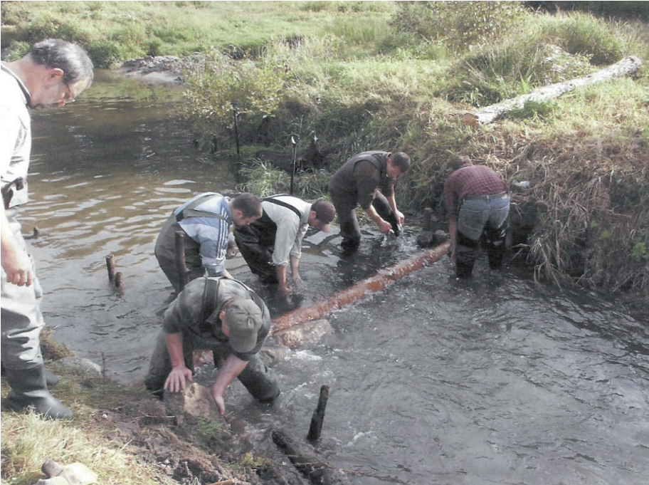
Fot. 10. Ułożenie bala drewnianego na początku tarliska.
